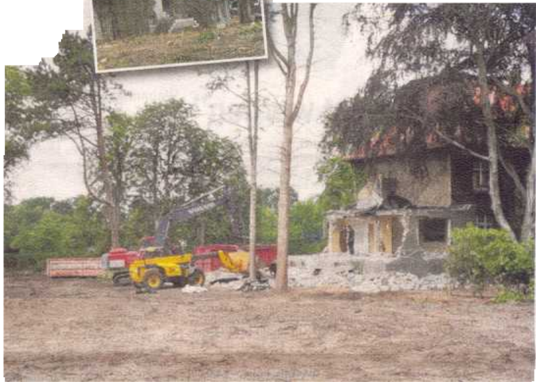
Mit schwerem Gerät rückten die Arbeiter am Sonnabend zum Abriss des Anbaus an
